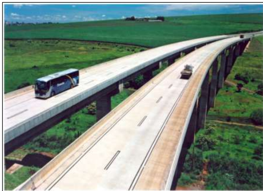
Viaduto do km 164
