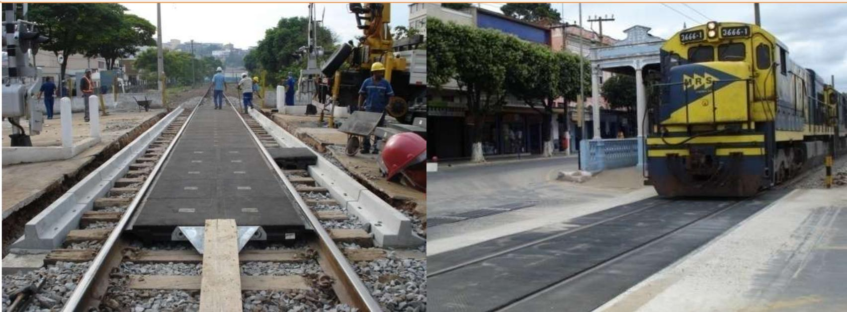
**A MRS realizou teste comparativo** entre **piso de borracha reciclada** e piso de concreto pré-moldado nas Passagens de Nível, soluções adotadas em diversos países para **oferecer melhores condições às comunidades**, uma vez que o pavimento asfáltico nestes locais tem vida útil reduzida, além de **agilizar a manutenção dessas PNs**.
